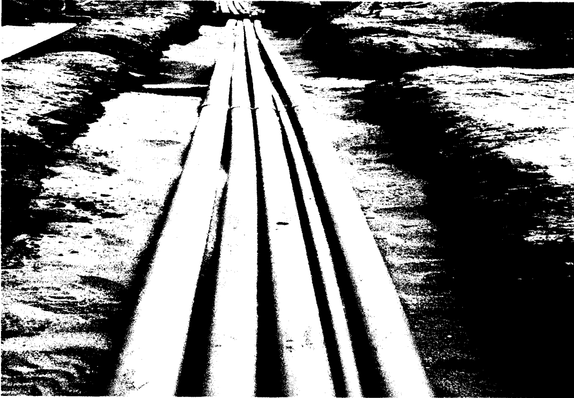
Foto N° 04: Tubería para alimentadores de 50mm en Patio cisterna de frio
