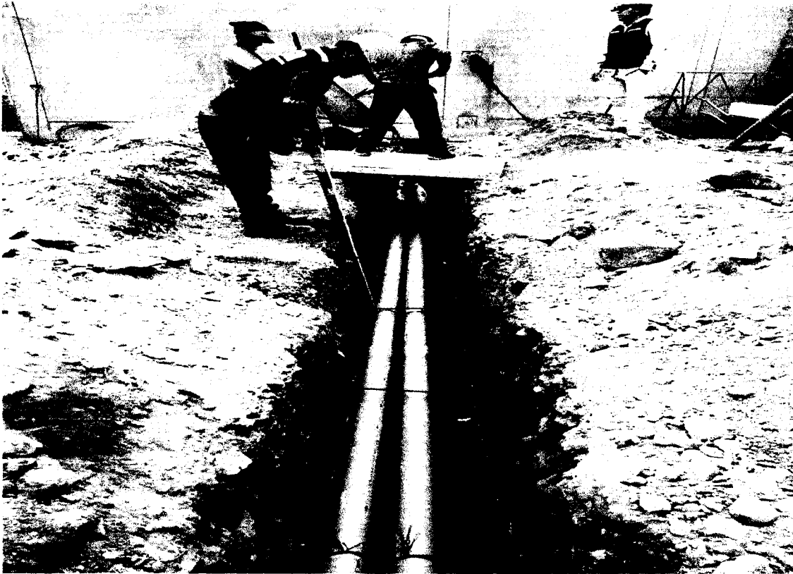
Foto N° 06: Tubería PVC SAP de 100 mm en Patio de Maniobras (Ducto de 02 Vias)
